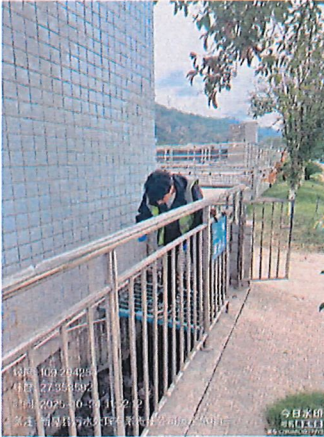
废水总排口 DW001
