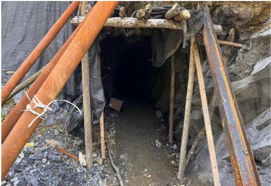
图 2.2.5-4 项目区隧洞现状
