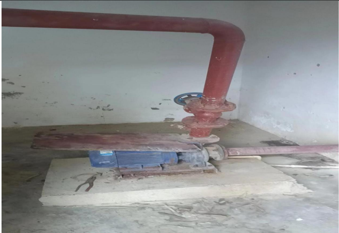
图2.2.5-4 项目区泵站现状
