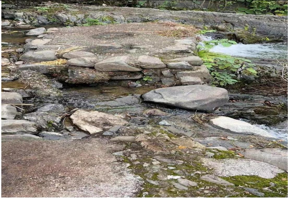
图 2.2.5-3 项目区拦溪坝现状
